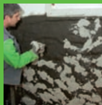
Nakładanie obrzutki renowacyjnej
