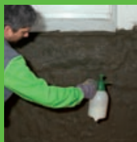
Gruntowanie KÖSTER Polysil® TG 500
